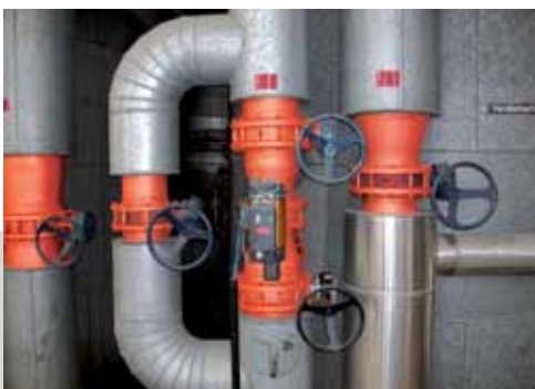
Unisolierte Anlagenbereiche sind rot markiert.
